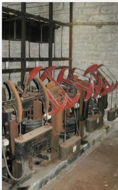
5- Parete sud-ovest. Trasformatori elettrici di Media-Bassa tensione a regolazione idraulica ora in disuso. Un tempo il locale era adibito a centralina di trasformazione elettrica e forniva corrente a tutte le utenze del centro storico (edifici, illuminazione, trasporti)
